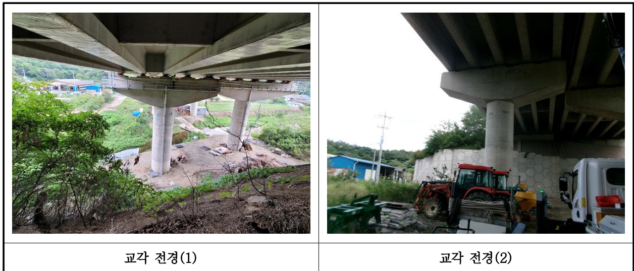
【사진 25.3.10】 교각 전경
