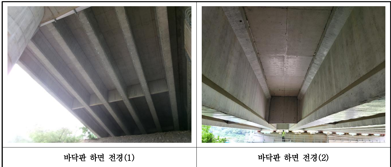
【사진 25.3.2】 바닥판 하면 전경
