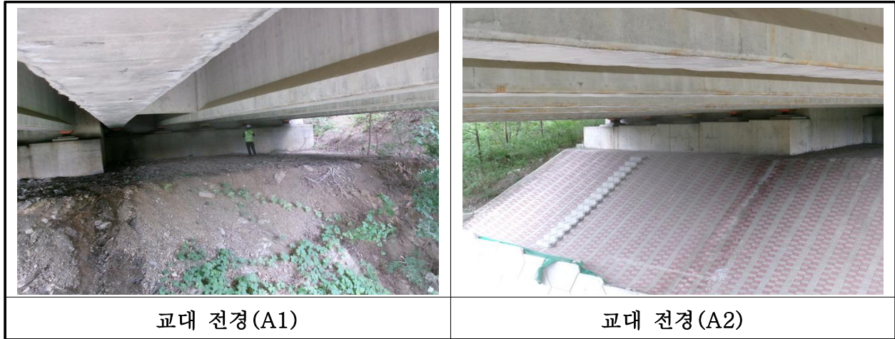
【사진 25.3.8】 교대 전경
