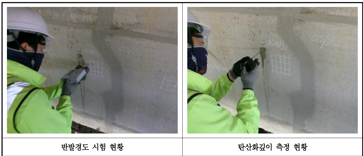
【사진 25.4.1】 콘크리트 내구성조사 현황
