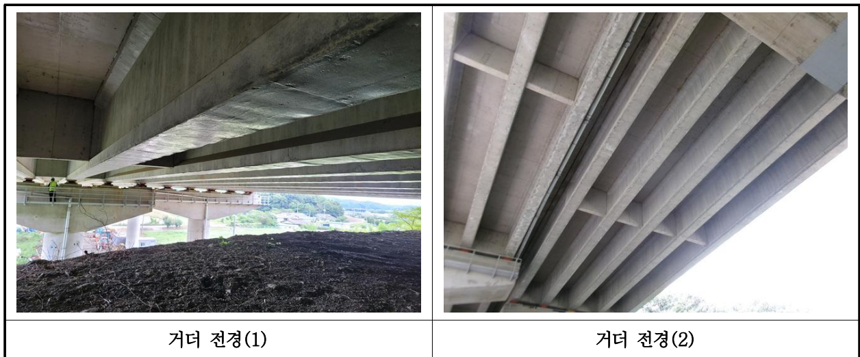
【사진 25.3.4】 거더 전경
