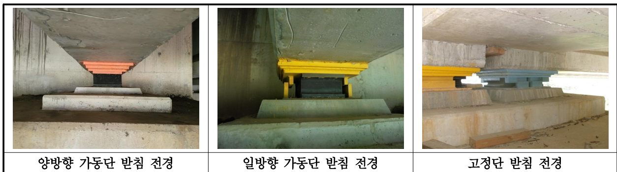
【사진 25.3.40】 교량받침 전경
