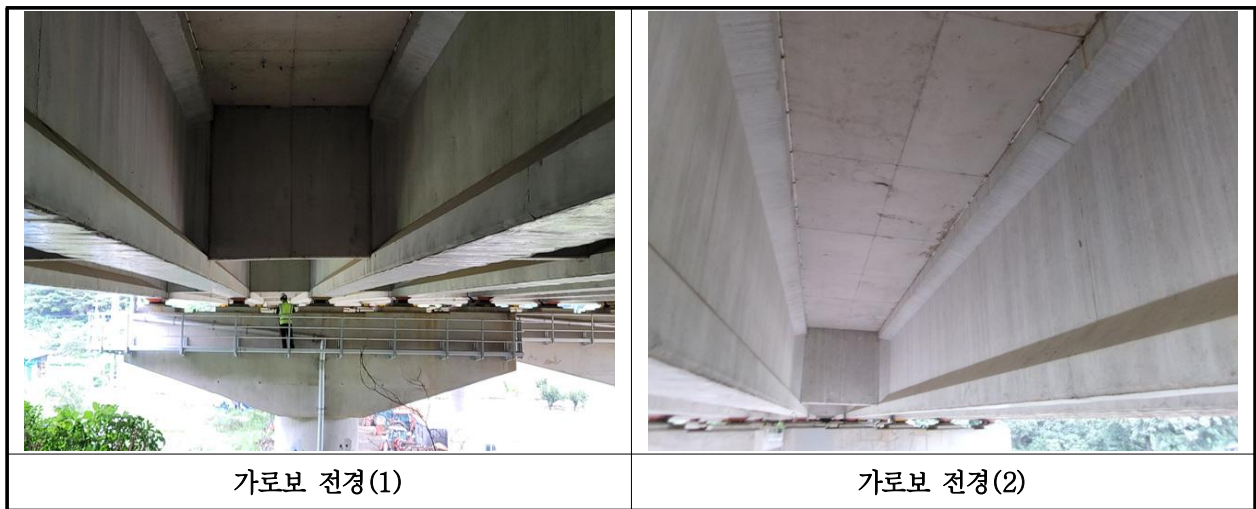
【사진 25.3.6】 가로보 전경
