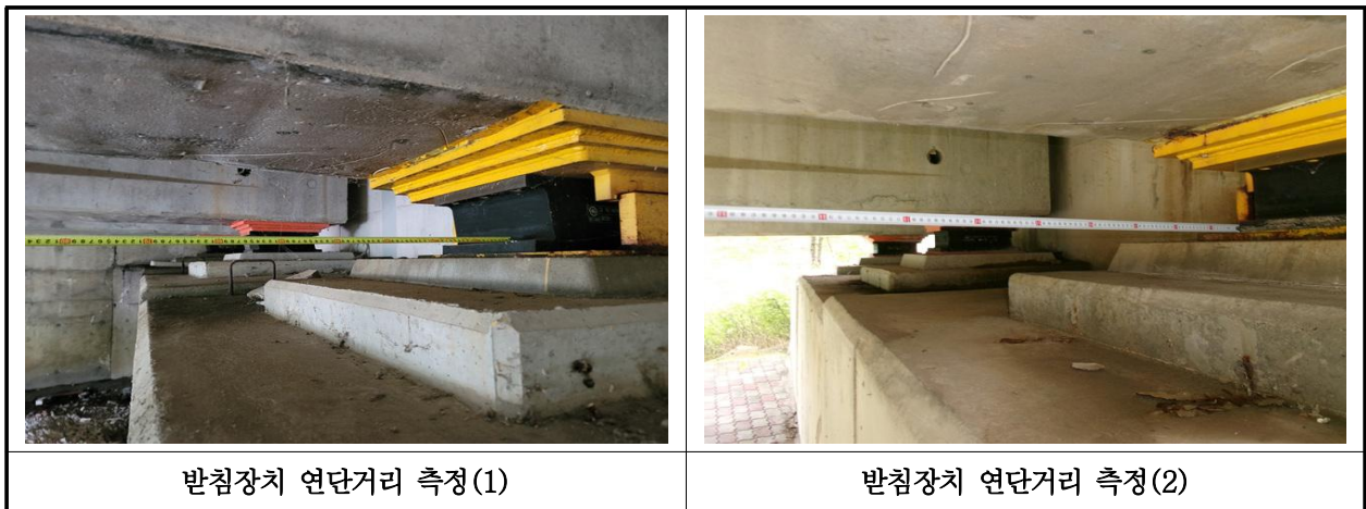
【사진 25.3.15】 교량받침장치 연단거리측정
