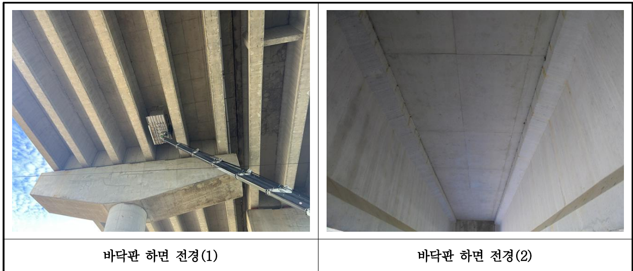
【사진 25.3.29】 바닥판하면 전경
