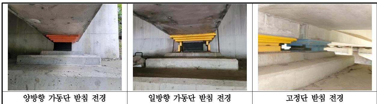
【사진 25.3.13】 교량받침 전경
