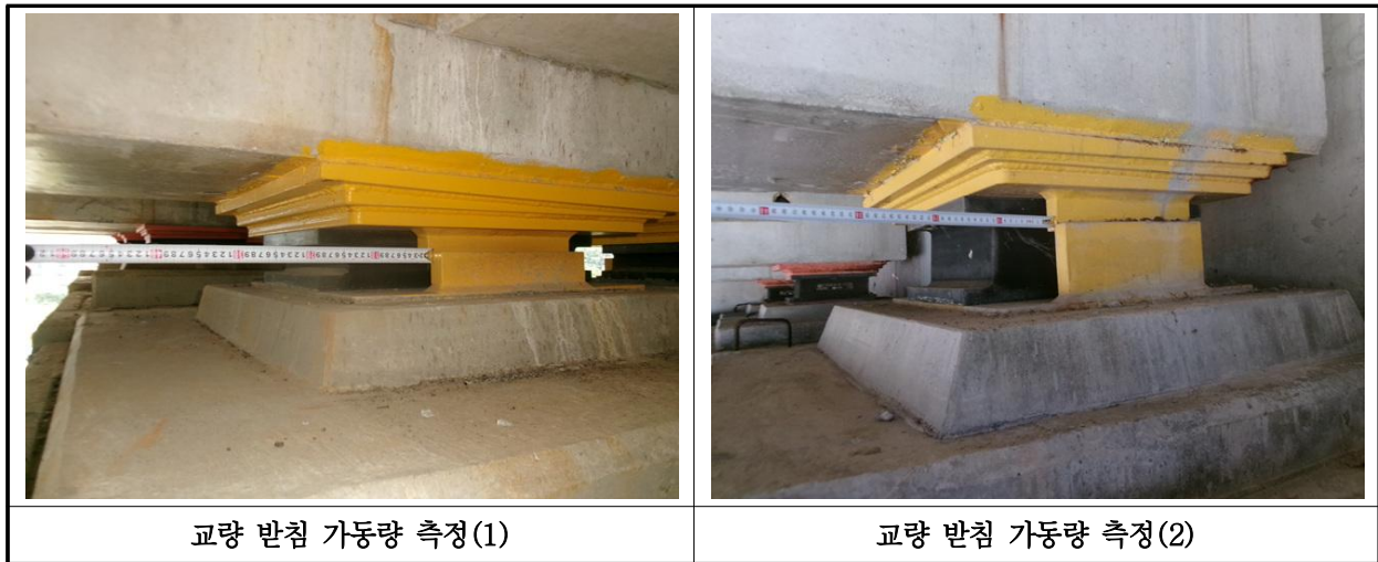
【사진 25.3.43】 교량받침 이동량 측정
