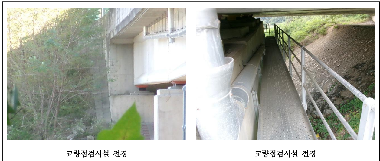
【사진 25.3.26】 교량 점검시설 전경
