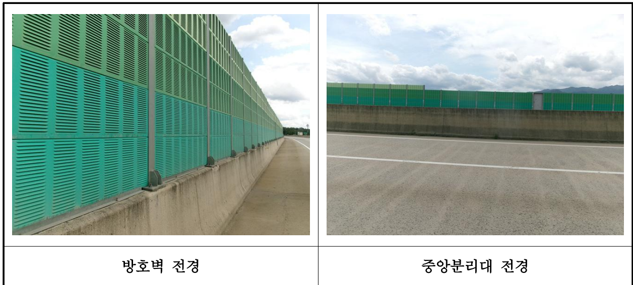
【사진 25.3.24】 방호벽 및 중앙분리대 전경
