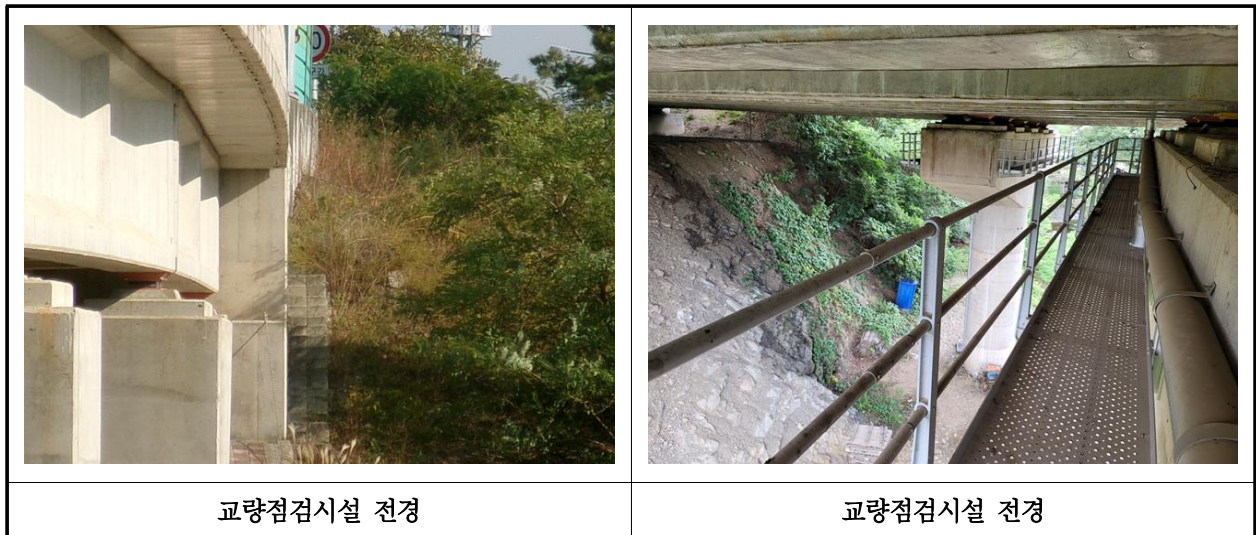
【사진 25.3.53】 교량 점검시설 전경
