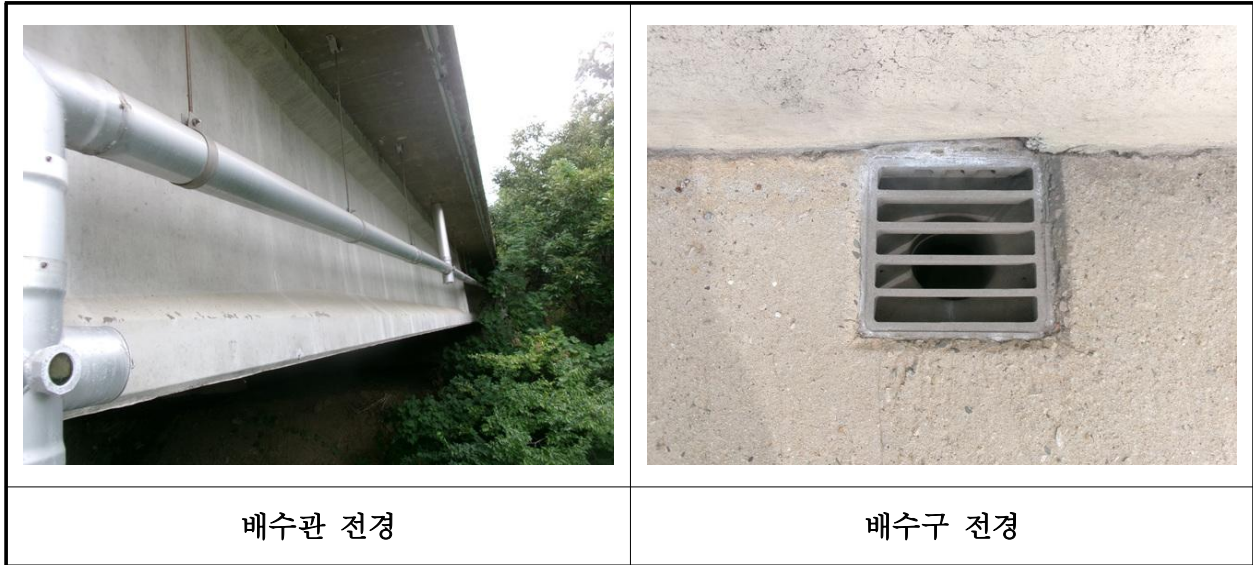
【사진 25.3.22】 배수시설 전경
