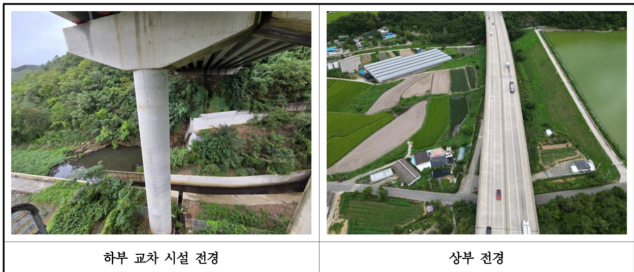
【사진 25.2.1】 부재 현장측정 전경
