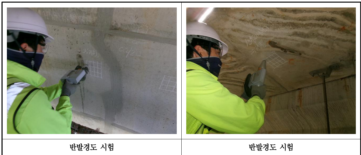
【사진 25.4.2】 반발경도시험 현장사진
