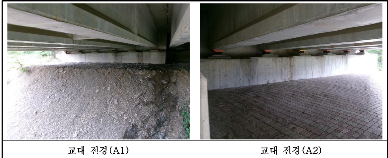
【사진 25.3.35】 교대 전경
