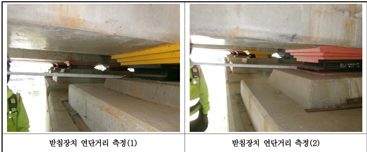
【사진 25.3.42】 교량받침장치 연단거리측정
