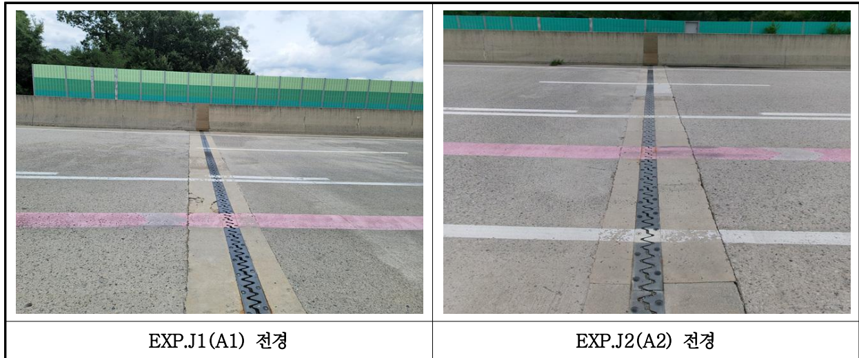
【사진 25.3.44】 신축이음장치 전경
