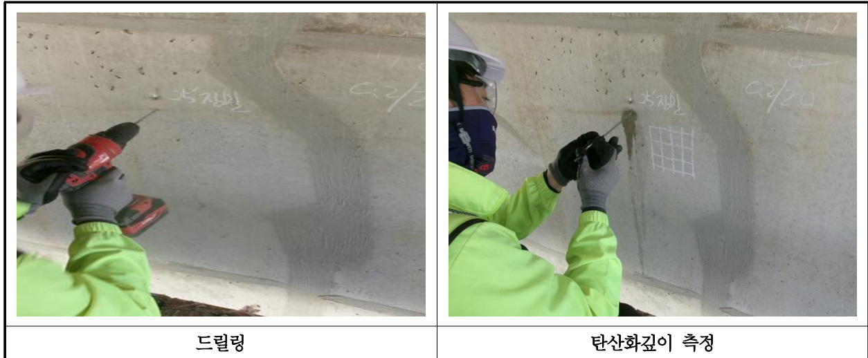
【사진 25.4.3】 탄산화 깊이 측정 현장사진
